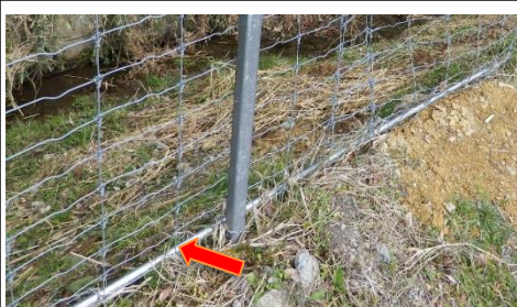
下部にパイプで補強
