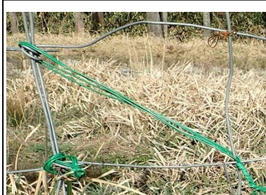
溶接が外れた所を 針金でタスキ掛け補強
